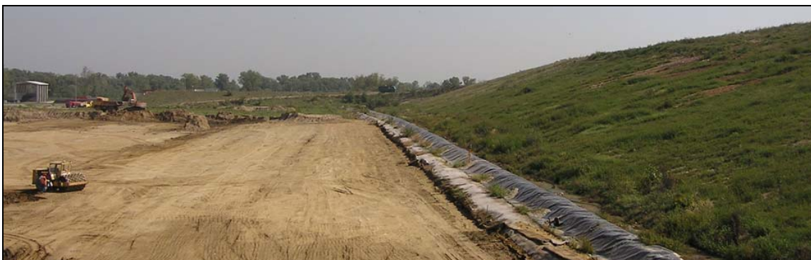
Slika 4: Postavljanje temeljnog brtvenog sustava na odlagalištu Prudinec/Jakuševac
