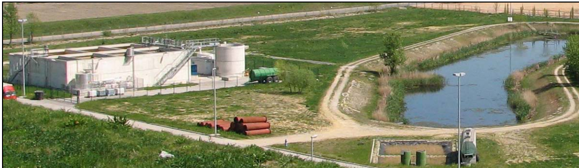
Slika 7. Uređaj za pročišćavanje procjednih voda (lijevo) i retencijski bazen (desno)
